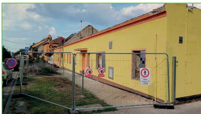
Demolice MŠ Havlíčkova (foto Pavel Kadlec)
